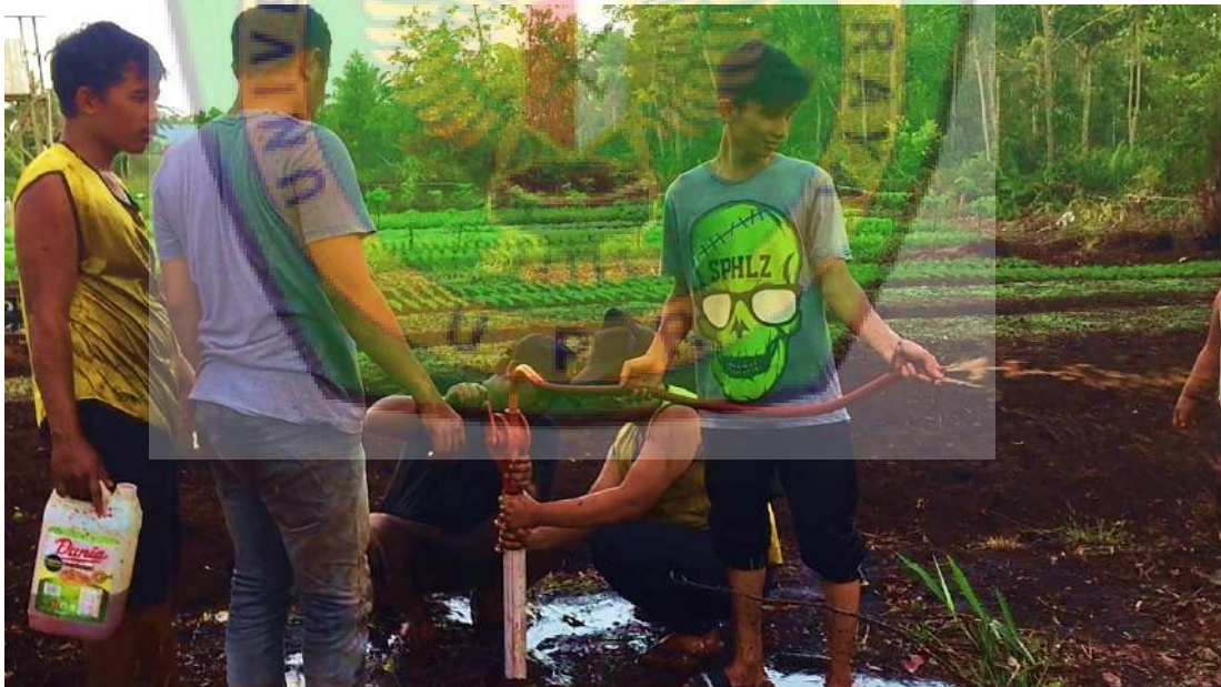
Gambar 3.7 Pengurasan Sumur Uji menggunakan Pompa Putar Manual
